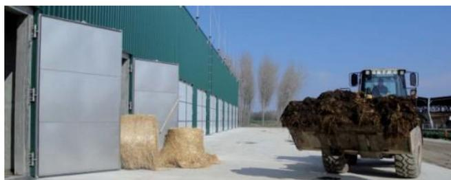
Figure 2 : Cellules de méthanisation par voie sèche, photo Bioferm Viessmann
