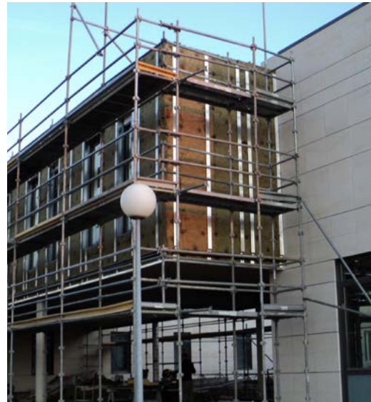
Implementation with insulation / Mise en oeuvre avec isolation
