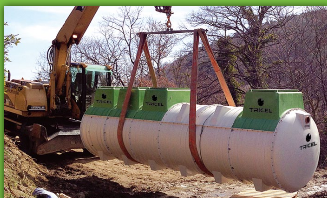
Installation d'une Tricel Novo FR20
