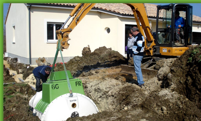
Installation d'une Tricel Novo FR6
