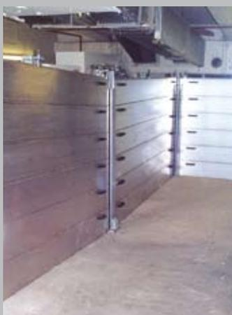
Nos barrages amovibles sont conçus pour fournir le même niveau d'étanchéité que les digues permanentes avec l'avantage d'être invisibles en temps normal : solidité, robustesse, efficacité alliés à la légèreté d'un équipement totalement démontable et rapide de mise en œuvre.
