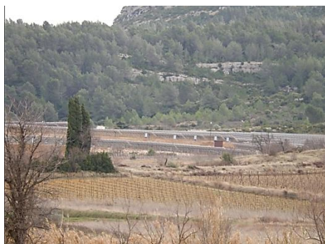
Depuis le village, la centrale se fait discrète
