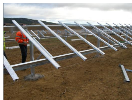
Pose des structures et alignement
