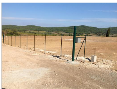
Préparation du terrain, pose de la clôture
