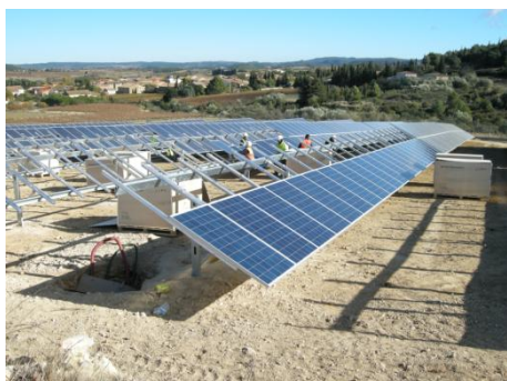
Mise en place des panneaux et câblage
