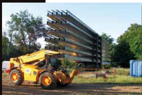
Transport des rails prêts à poser
