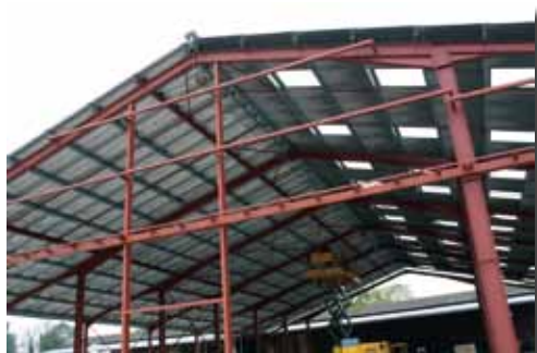
Toiture en cours de montage
