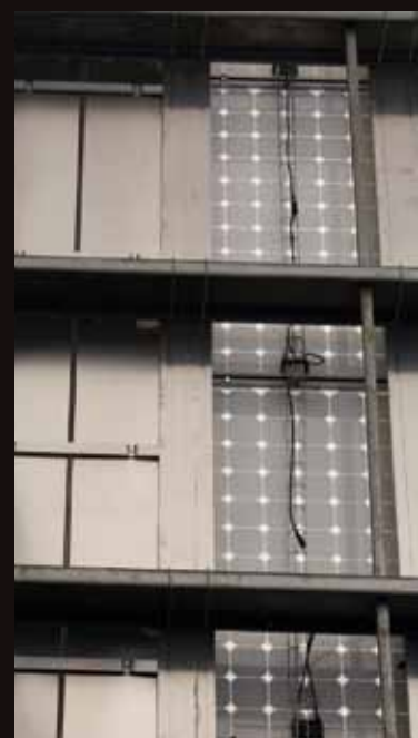
Tôles en cours de montage
