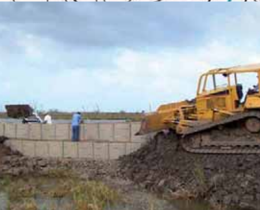
RÉPARATION DE BRECHES
