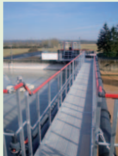
Passerelle station de traitement des eaux
