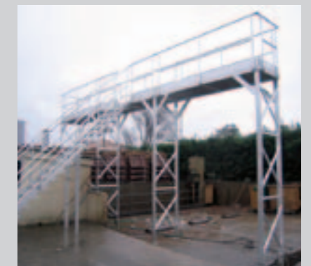
Passerelle pour nettoyage des bennes
