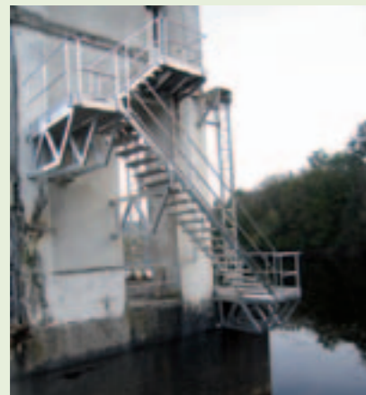
Escalier accès barrage
