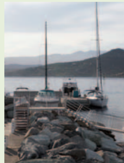
Passerelle d'accès ponton port de plaisance
