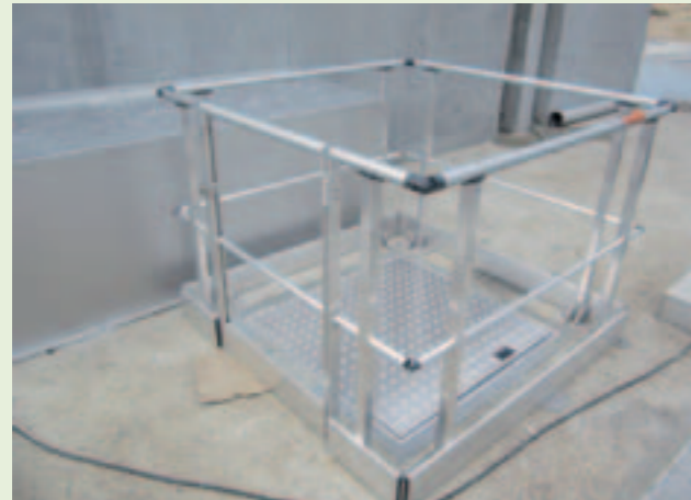
Garde-corps + trappe étanche
