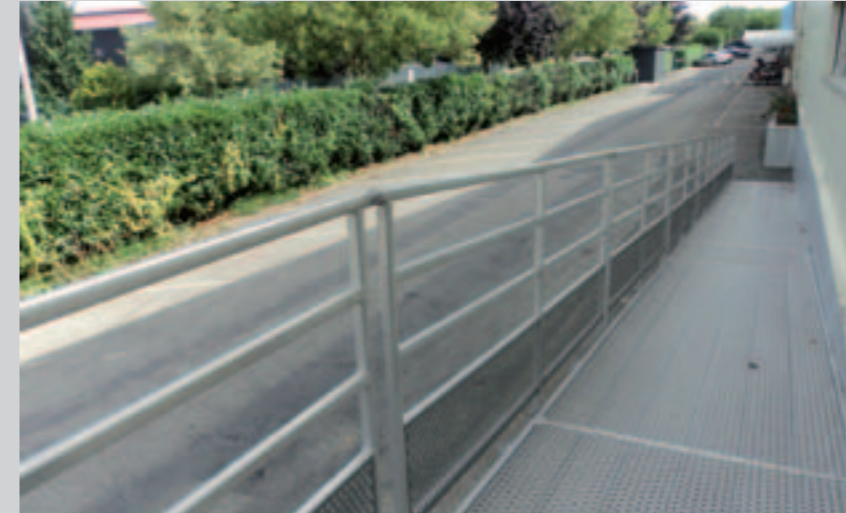
Rampe d'accès extérieure bâtiment industriel
