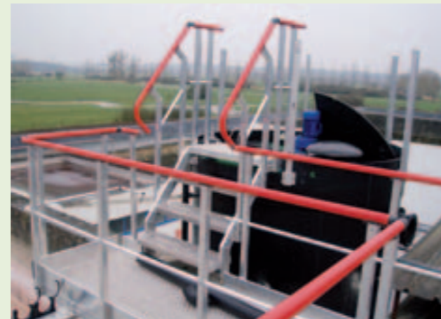
Garde-corps et escalier d'accès sur passerelle
