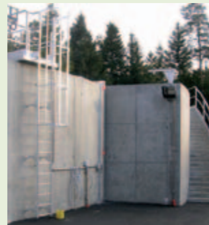
Echelle d'accès + garde-corps d'escalier
