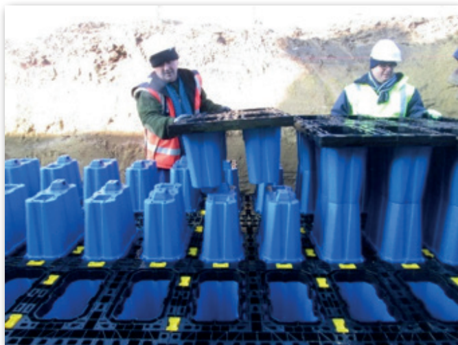
Légers et manportables, les modules AZbox sont faciles à installer et optimisent les coûts de mise en oeuvre
