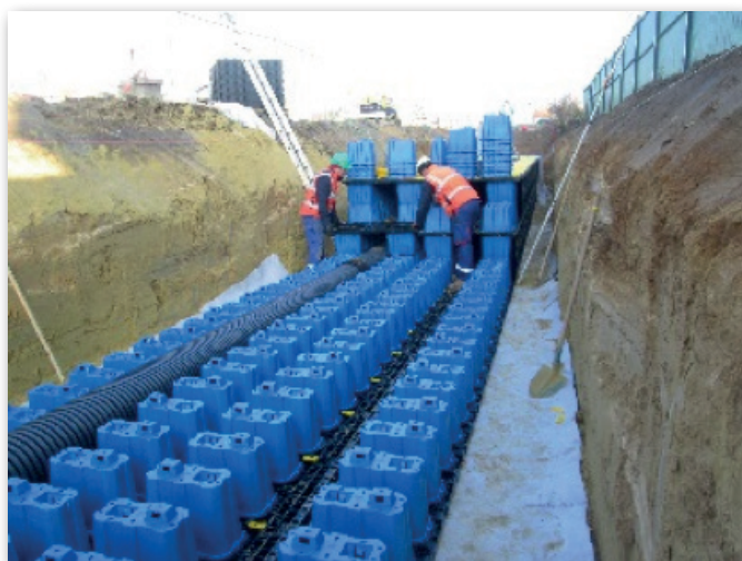
AZbox : une solution alternative à l'assainissement traditionnel, désengorgeant les réseaux de distributeur
