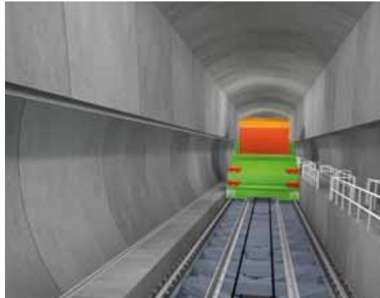
Transfert par funiculaire dans une descenderie.
