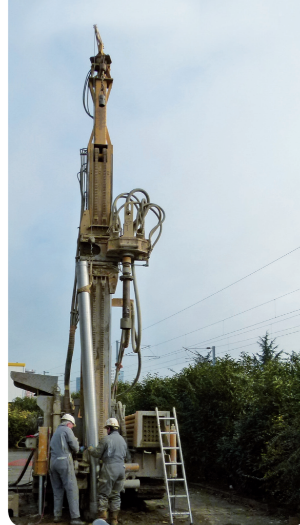
Mise en place d'un puits géothermique pour PAC sur EST
