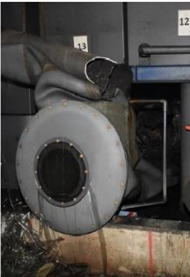
Figure n°3 : gaine d'aspiration en PVC
