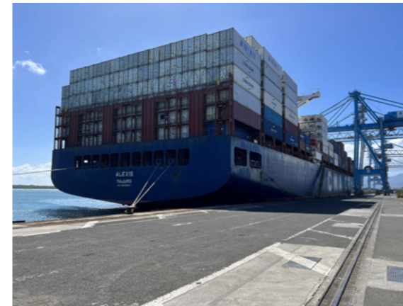
Extension confortement quais GPM de la Guadeloupe
