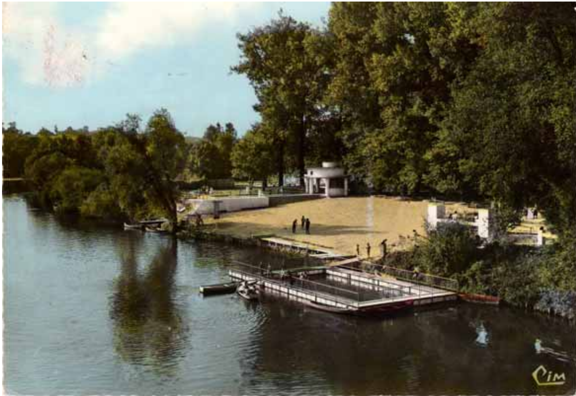
Figure 13 : La plage d'Esbly. Bien que de taille modeste, elle propose une baignade de pleine eau et un bassin constitué de pontons métalliques préfabriqués. © Coll. part.
