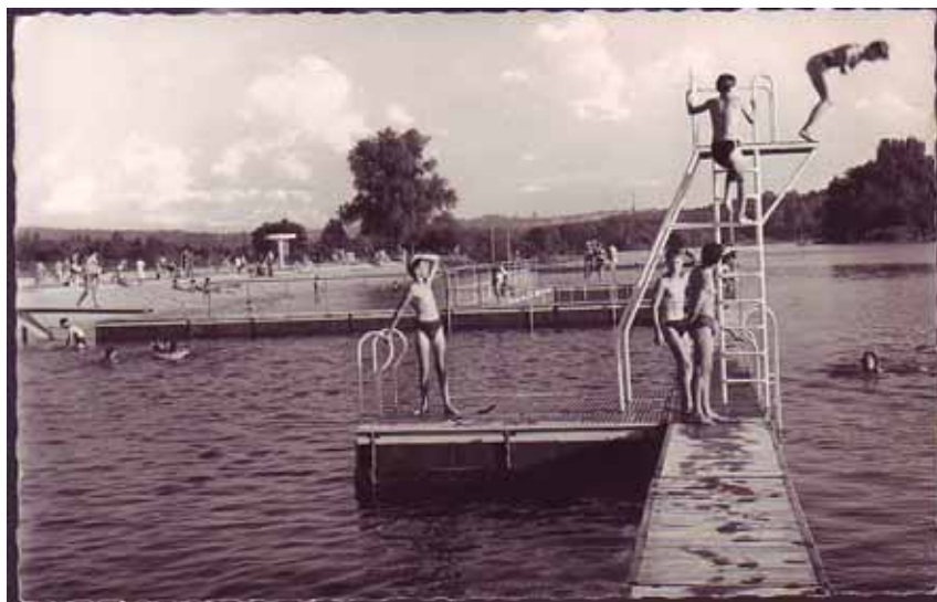
Figure 12 : Les pontons préfabriqués, modulables et démontables de la plage de Meaux. © Delcampe.fr.
