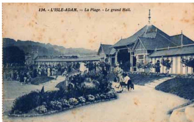
Figure 28 : Le hall et les galeries de cabines de la plage de l'Isle-Adam © Coll. part.
