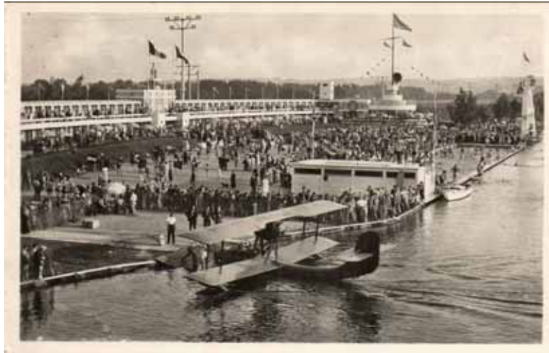
Figure 27 : La plage de Boran –Les Lys – Chantilly © Delcampe.fr. L'ensemble des bâtiments d'accueil et techniques (au centre de l'image les installations de filtration) du bassin.
