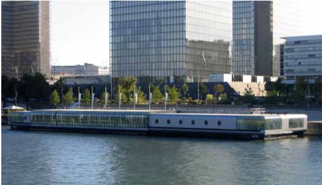
Figure 43 : La piscine Joséphine-Backer, dispositif de couverture fermé, vue depuis le quai de la rive droite. © Wikipedia. [consulté le 01/02/2011]
