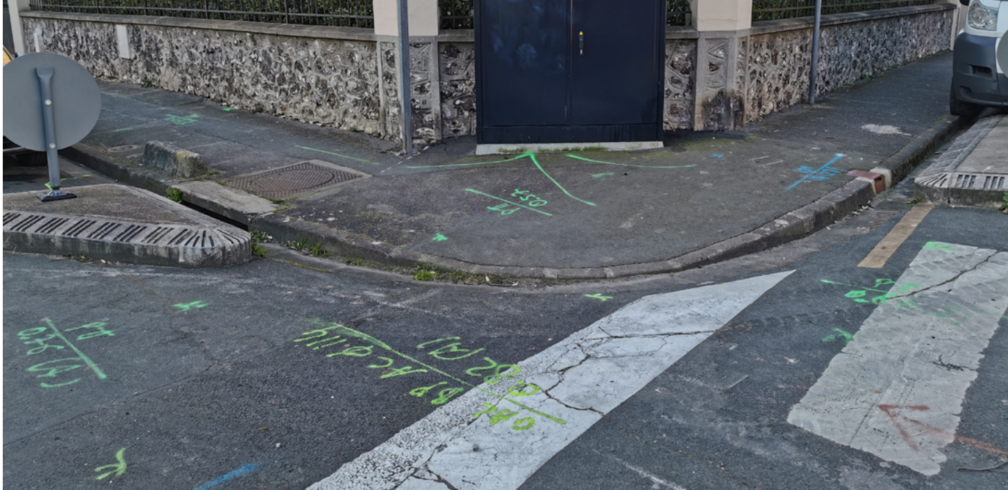
Marquage-piquetage préalable à des travaux de voirie pour localiser les différents réseaux souterrains existants - Février 2022 | Crédit : DRIEAT Île-de-France
