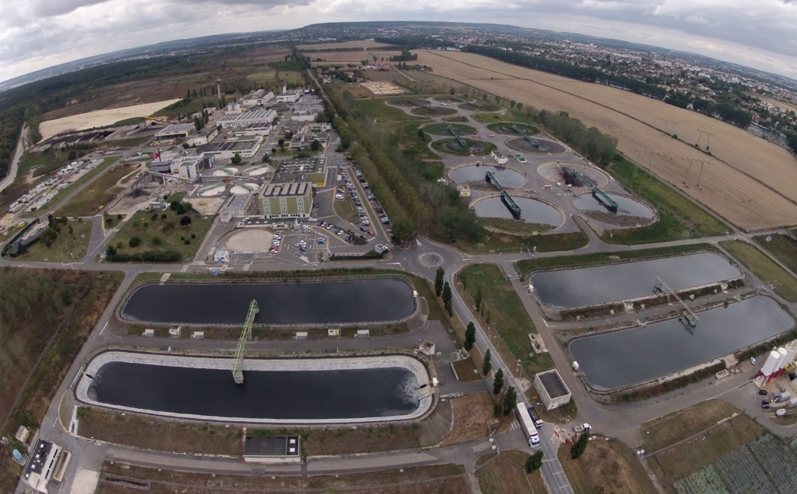
Photo aérienne de la station d'épuration d'Achères - Septembre 2012 | Crédit : ToucanWings / Wikipedia
