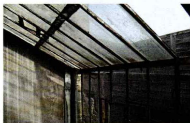
Cour avant curetage
