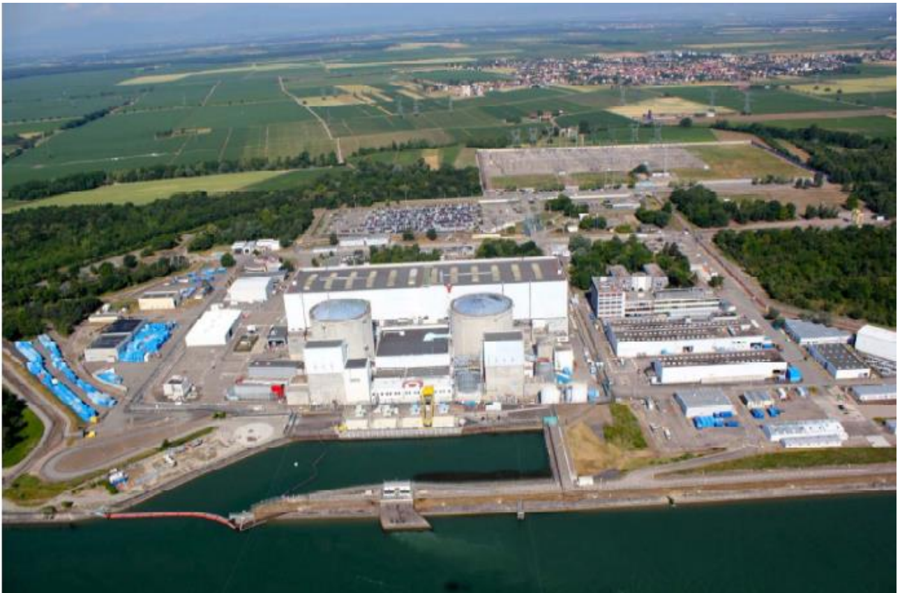
Figure 2 : Vue du CNPE. Le Grand canal d'Alsace est au premier plan (source : dossier).
