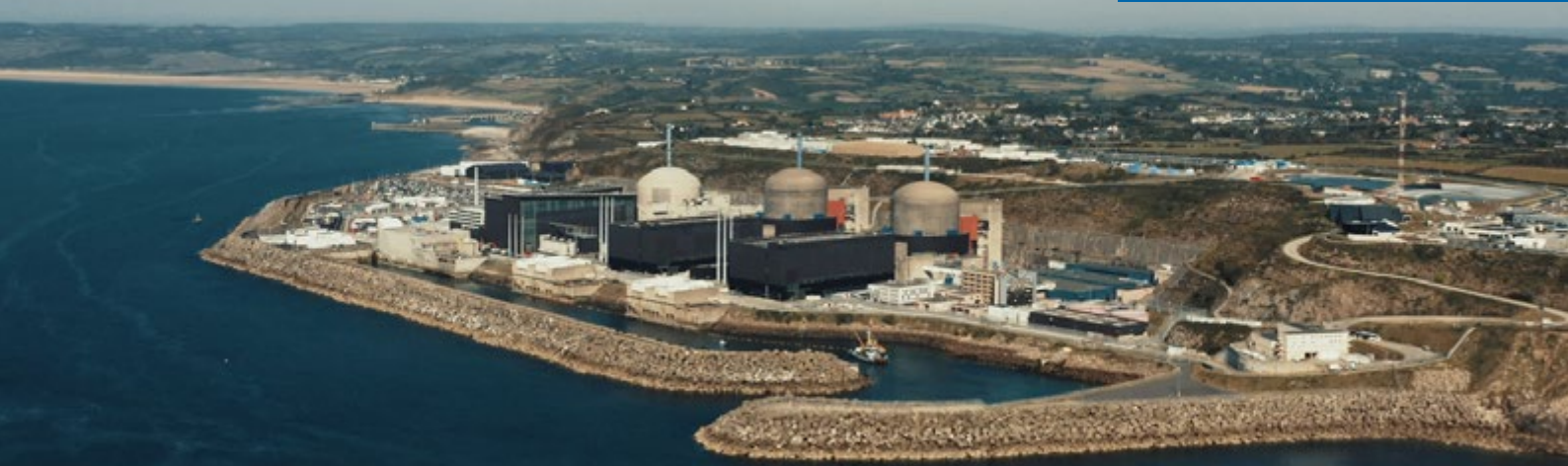
Vue aérienne de la centrale de Flamanville (Manche) © EDF Flamanville
