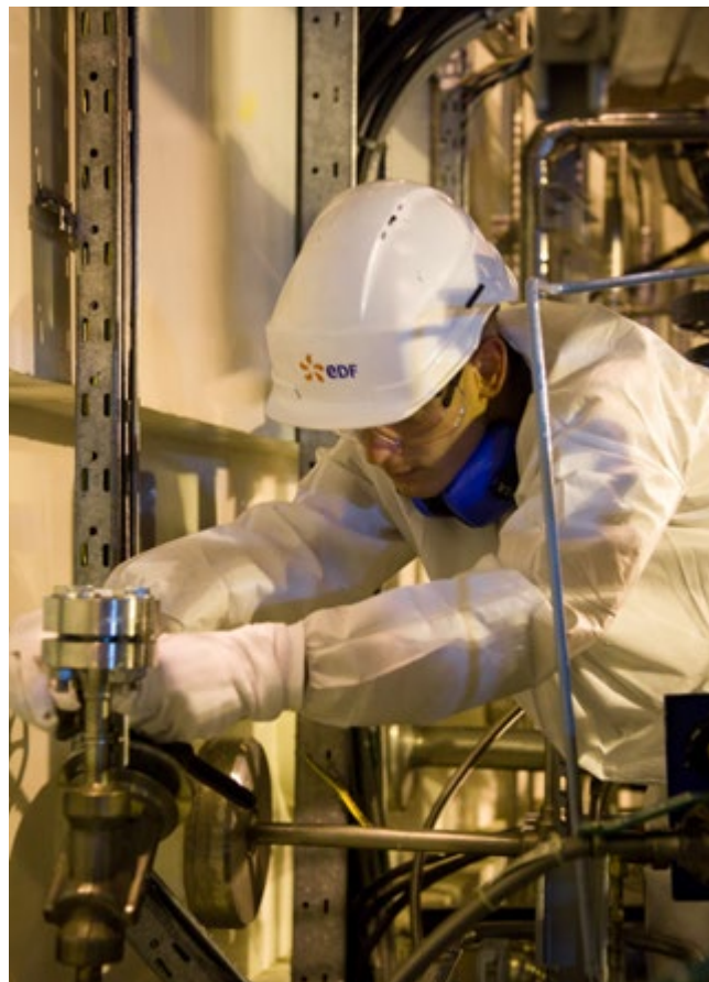
Intervention dans le bâtiment réacteur n°3 de la centrale de Cattenom (Moselle) © David Queyrel
