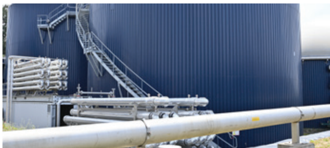
Site de méthanisation à Château-Gontier (53)
