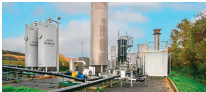
Centre d'enfouissement de Saint-Palais (18)
