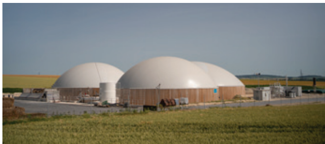
Site de méthanisation à Puisieux (51)
