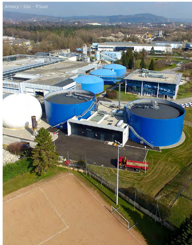
La STEU d'Annecy (234 500 EH) est la STEU de plus petite capacité disposant de 2 digesteurs mésophiles en parallèle. Ces digesteurs ont été conçus pour évoluer, à terme, en fonctionnement thermophile.
