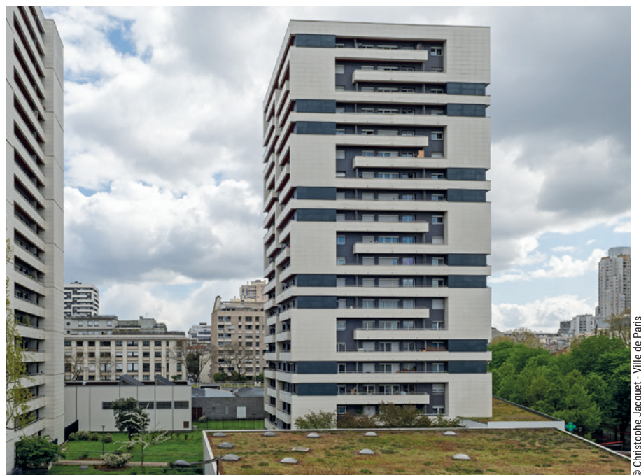
Vu sur une des tours de la Cité Michelet construite à la fin des années 1960 - Paris 19 e - Paris Habitat raccordé au réseau CPCU, 1 777 logements - Réhabilitation Plan Climat achevée en 2015
